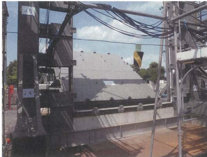
パネル開放試験状況
