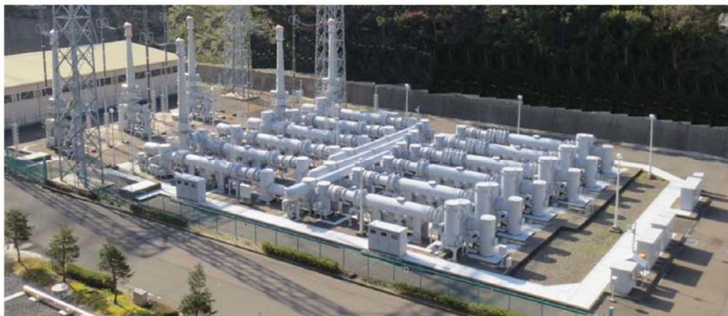
(ガス絶縁開閉装置イメージ図)
