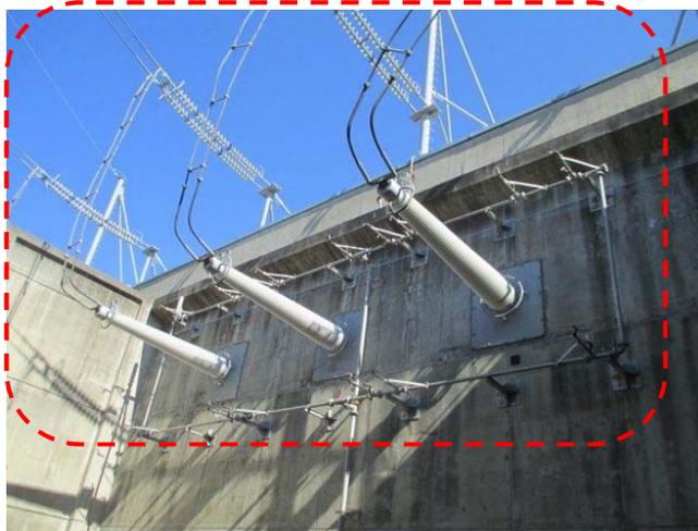
(275kV 超高圧開閉所 送電線引き込み部イメージ)
