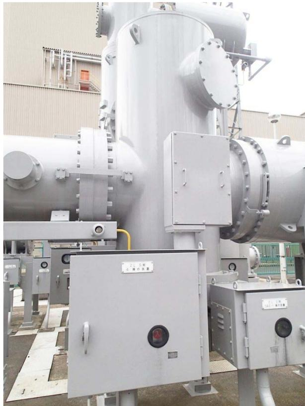
図 1-26 断路器の外観（開閉状態確認イメージ）
