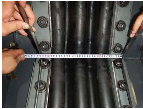
ボルトピッチ計測状況
