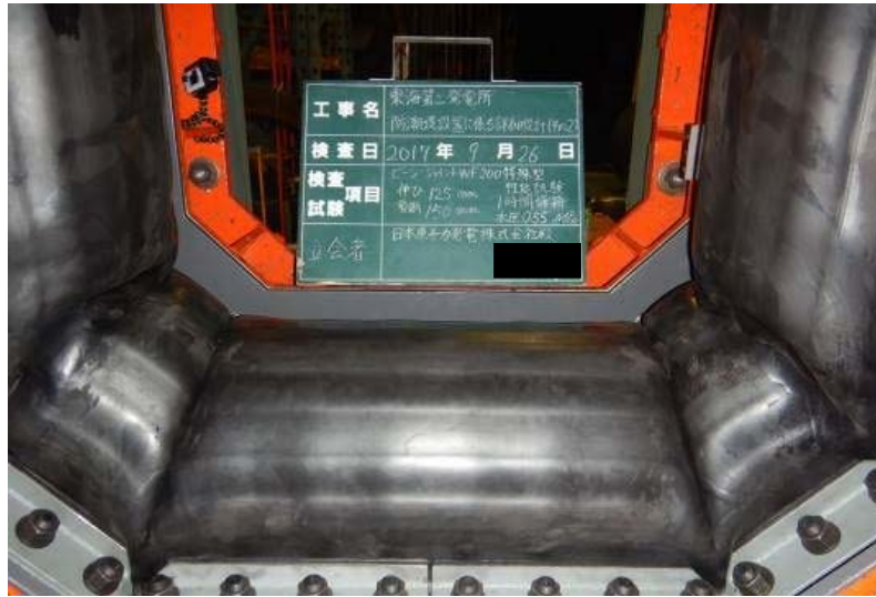
底版・側壁（漏えいなし）
