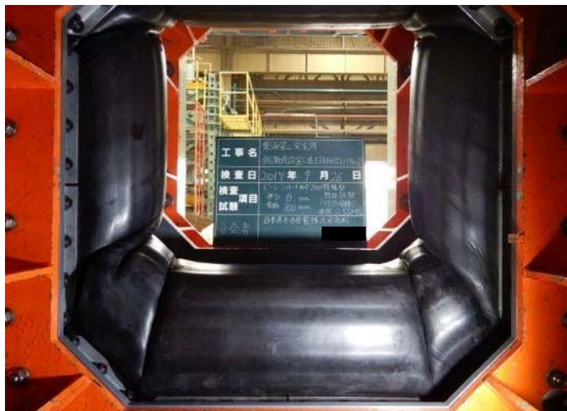
底版・側壁（漏えいなし）
