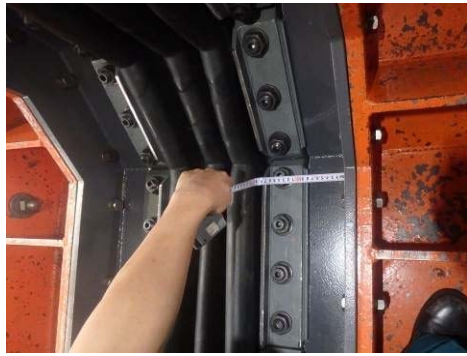
枠-ボルト間距離計測状況
