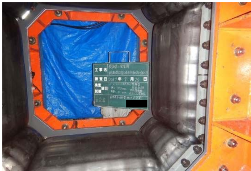
側壁 (漏えいなし)
