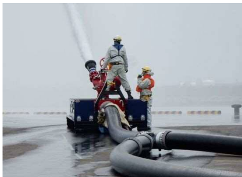
放水砲による放水（直状放射）
