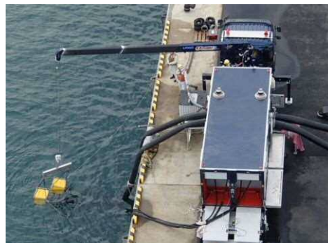
水中ポンプの設置状況
