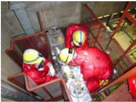
連絡配管閉止フランジ切替え訓練
