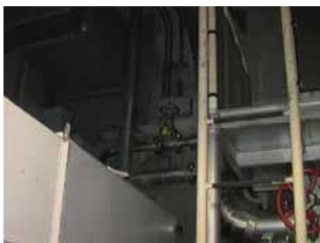
系統構成 (補助ボイラ冷却水元弁)
