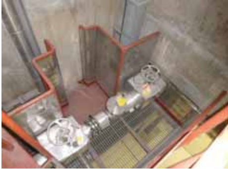
作業場所（全体）
