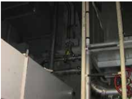
系統構成 (補助ボイラ冷却水元弁)
