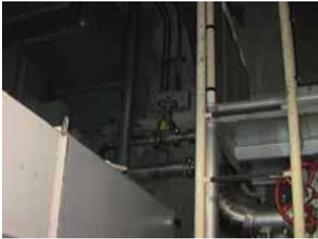
系統構成 (補助ボイラ冷却水元弁)
