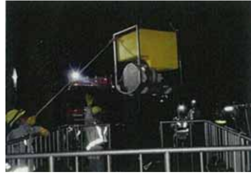
夜間での送水訓練（ポンプ設置）
