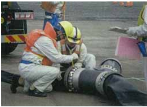
ホース接続訓練
