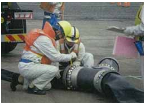
ホース接続訓練
