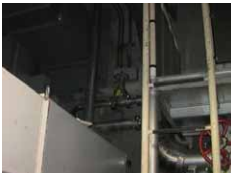
系統構成 (補助ボイラ冷却水元弁)
