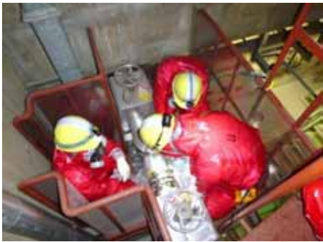
連絡配管閉止フランジ切替え訓練
