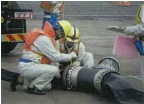
ホース接続訓練
