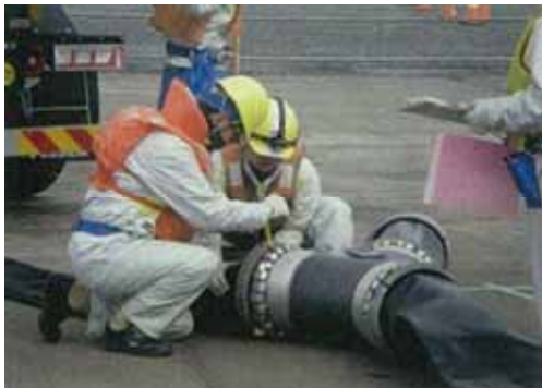
ホース接続訓練
