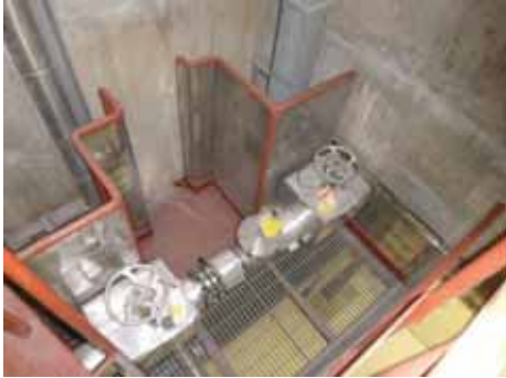
作業場所（全体）
