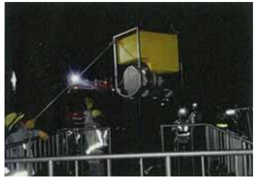
夜間での送水訓練（ポンプ設置）
