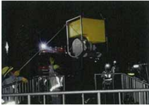
夜間での送水訓練（ポンプ設置）
