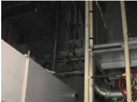
系統構成 (補助ボイラ冷却水元弁)
