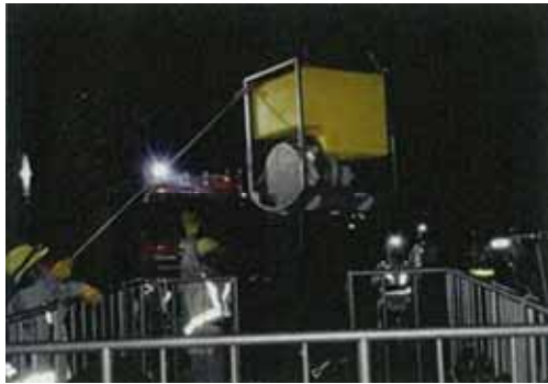
夜間での送水訓練（ポンプ設置）
