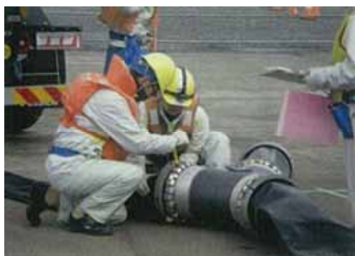
ホース接続訓練
