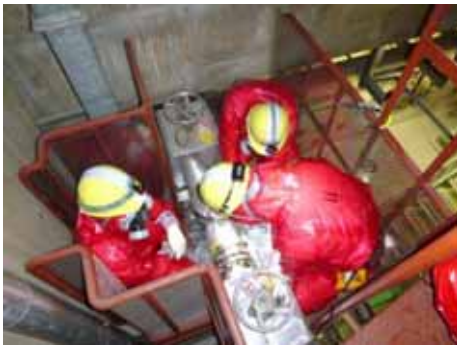
連絡配管閉止フランジ切替え訓練
