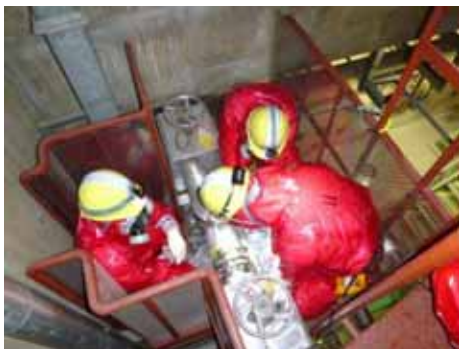
連絡配管閉止フランジ切替え訓練
