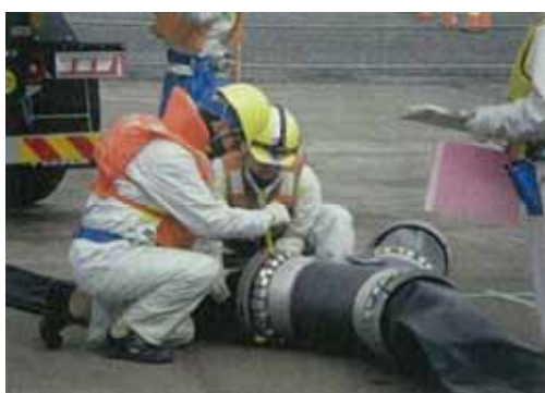
ホース接続訓練
