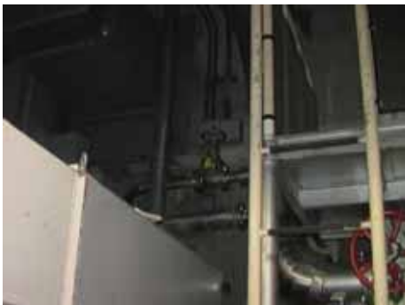
系統構成 (補助ボイラ冷却水元弁)
