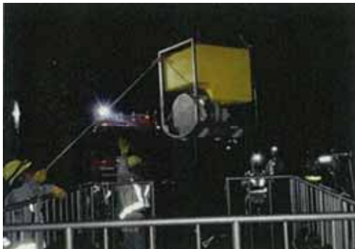
夜間での送水訓練（ポンプ設置）
