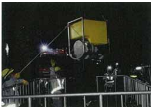
夜間での送水訓練（ポンプ設置）
