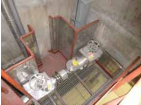
作業場所（全体）
