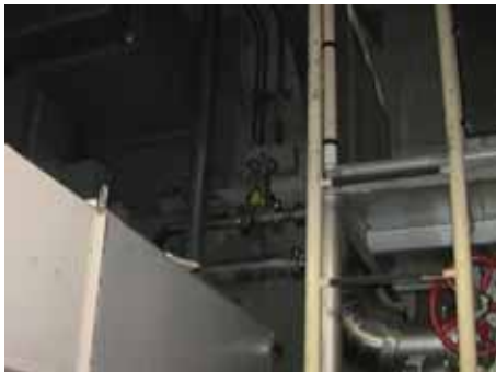
系統構成 (補助ボイラ冷却水元弁)
