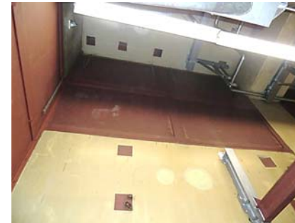
室内よりの状況 (3階 3F2)
