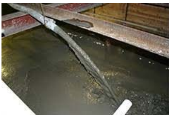
図 5.15-9 流動化処理土打設状況
