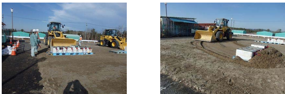
第 8-6 図 がれき撤去検証の写真
