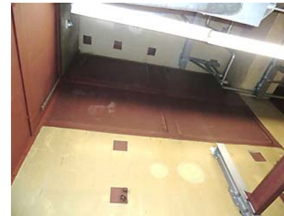
室内よりの状況 (3階 3F2)
