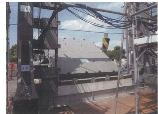
実機大ブローアウトパネル開放試験のイメージ (2012年 自主的安全性向上の一環として、原子炉建屋6階北側強制開放装置設置時の試験例)
