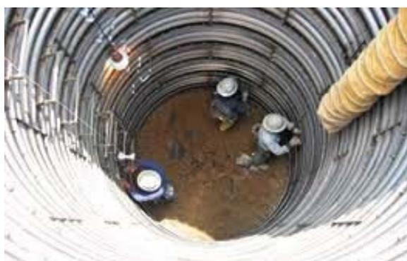
図 5.15-5 ライナープレート施工状況
