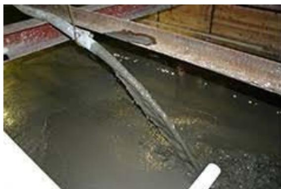
図 5.15-9 流動化処理土打設状況
