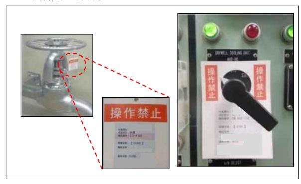
第2.3-1図 操作禁止札による識別(例)
