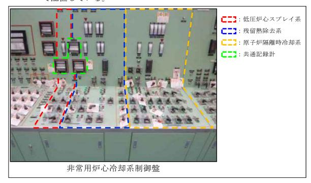
第2.1-4図 制御盤の系統分割(例)
