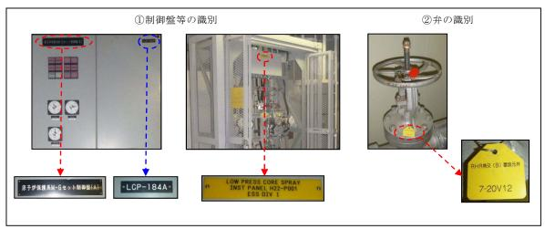
第2.2-3図 制御盤等及び弁の識別管理(例)
