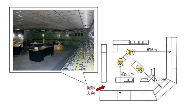
図 1-1-4-1 シミュレーション施設における可搬型照明(SA)確認状況
