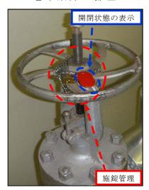
弁開閉状態表示 通常開:赤 通常閉:緑 調整開:黄
