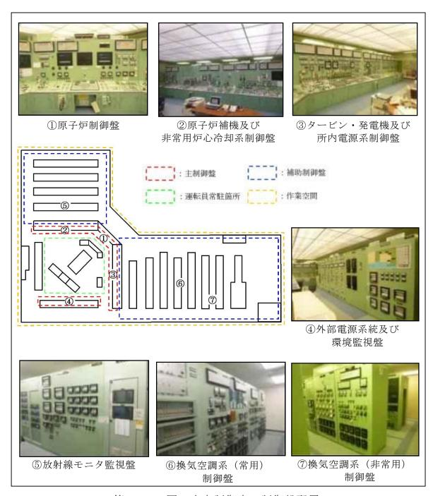
第2.1-1図 中央制御室の制御盤配置
