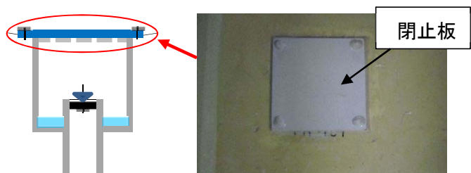
第 9.11-13 図 床ドレンファンネルの閉止例
