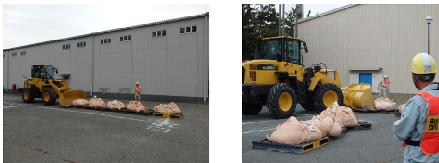
第 8-4 図 がれき撤去検証の写真
