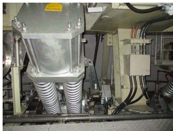
第 6 図 主蒸気内側隔離弁
