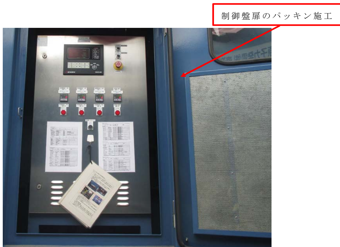
第 2 図 制御盤扉のパッキン施工
