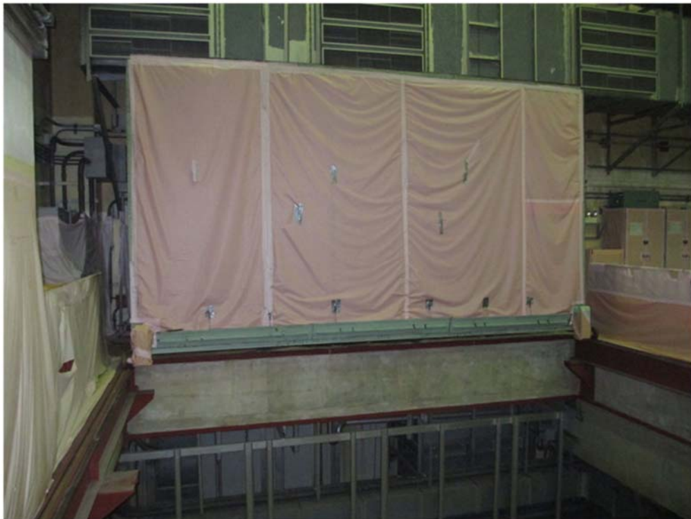
第 1 図 大物搬入口ハッチ（開状態）
