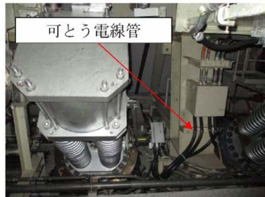
機器へのケーブル取合状況 (主蒸気内側隔離弁との取合)
