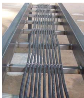
(シート施工前)
