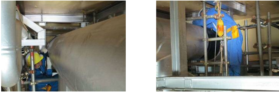
第2図 狭隘部作業状況
