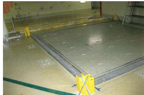
支柱レールの取付状況
