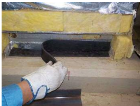
第7図 床貫通部模擬作業状況
