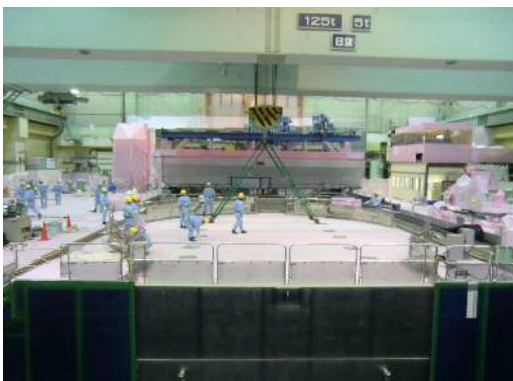
使用済燃料プール周り（全体）
