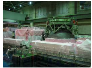
原子炉建屋原子炉棟 6階東側
