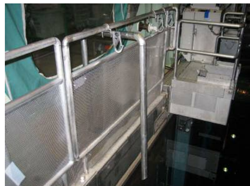
使用済燃料プール周り（手摺り）
