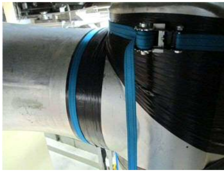
第3図 修復模擬作業状況
