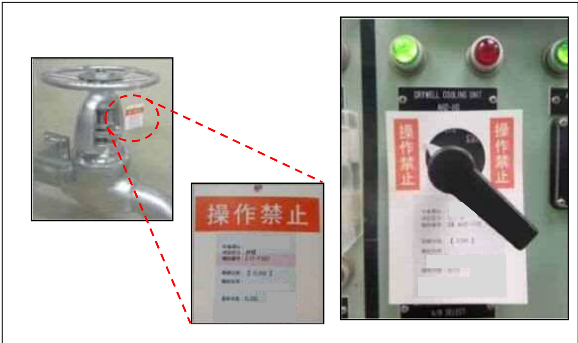
第 2.4.3-1 図 操作禁止札による識別 (例)
