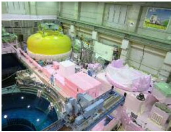
原子炉建屋原子炉棟 6階西側
