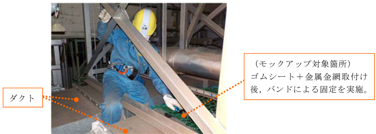
第5図 狭隘部作業状況
