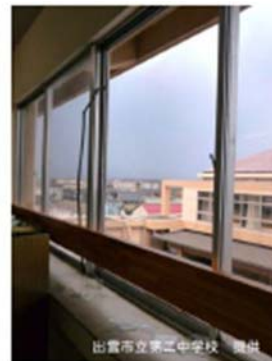
屋外に面した窓ガラス
