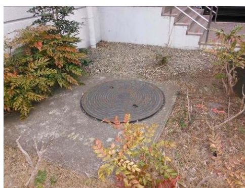
#49 マンホール蓋
