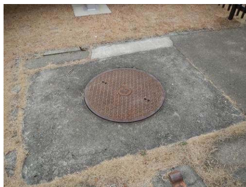
#246 マンホール蓋
