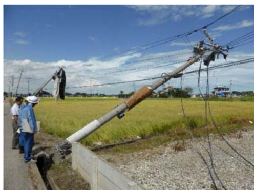
電柱の倒壊
