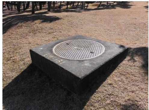
#186 マンホール蓋
