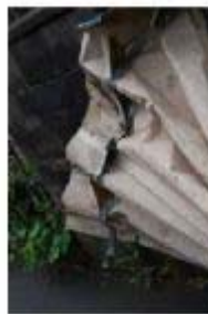
飛散した折板屋根の損傷状況
