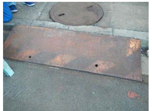
#335 鋼製スロープ
