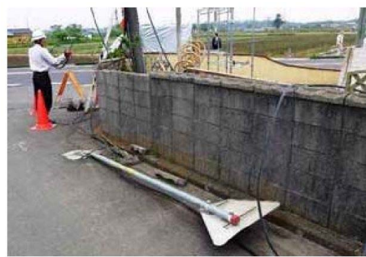
道路標識の倒壊
