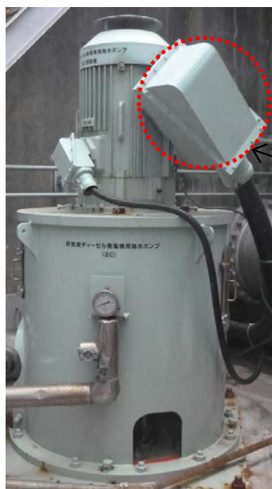
第 2.4.2-7 図 非常用ディーゼル発電機（高圧炉心スプレイ系ディーゼル発電機を含む。）用海水ポンプ電動機 構造図
