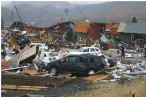
全壊した工事事務所周辺
