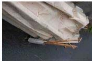
飛散した折板屋根の損傷状況
