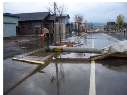
道路側へ倒壊した電柱
