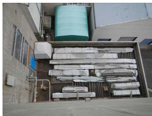
#301 足場板, 足場枠
