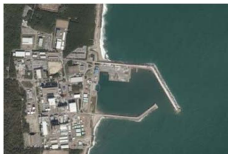
写真① 東海第二発電所全景
