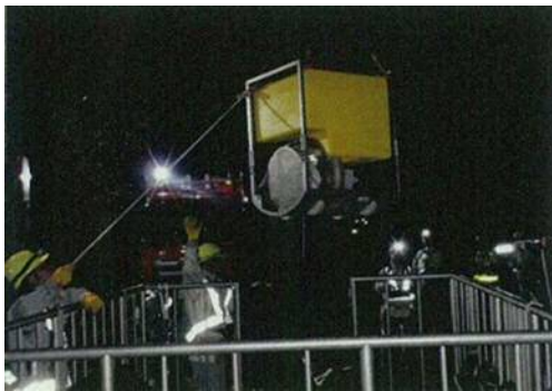
夜間での送水訓練（ポンプ設置）
