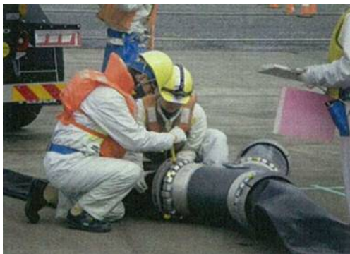
ホース接続訓練
