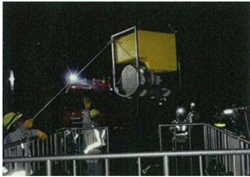
夜間での送水訓練（ポンプ設置）
