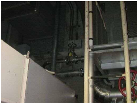
系統構成 (補助ボイラ冷却水元弁)
