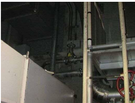
系統構成 (補助ボイラ冷却水元弁)
