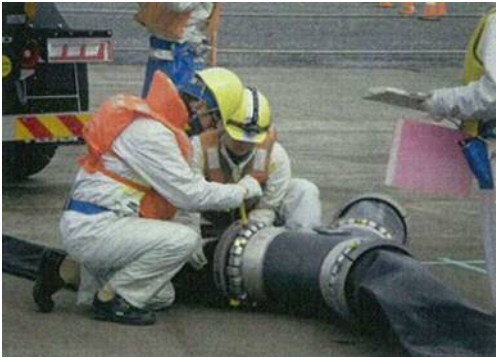
ホース接続訓練
