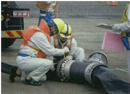
ホース接続訓練
