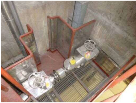
作業場所（全体）
