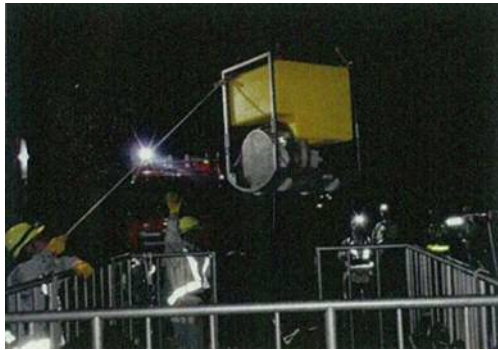
夜間での送水訓練（ポンプ設置）
