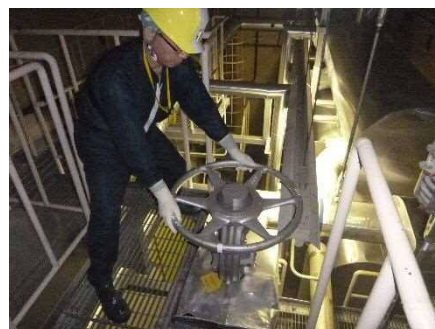
原子炉冷却材浄化系 再生熱交換器バイパス運転操作 (原子炉冷却材浄化系再生熱交換器バイパス弁)
