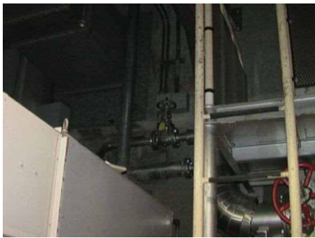
系統構成 （補助ボイラ冷却水元弁）
