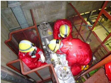
連絡配管閉止フランジ切替え訓練
