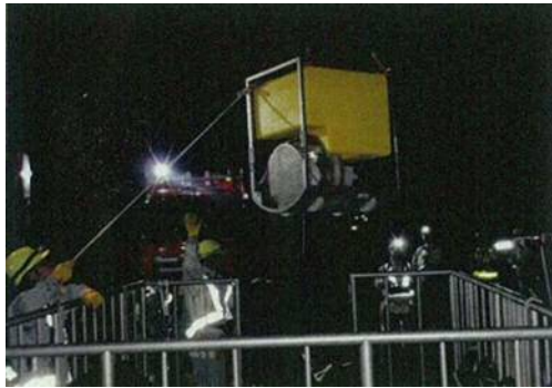
夜間での送水訓練（ポンプ設置）
