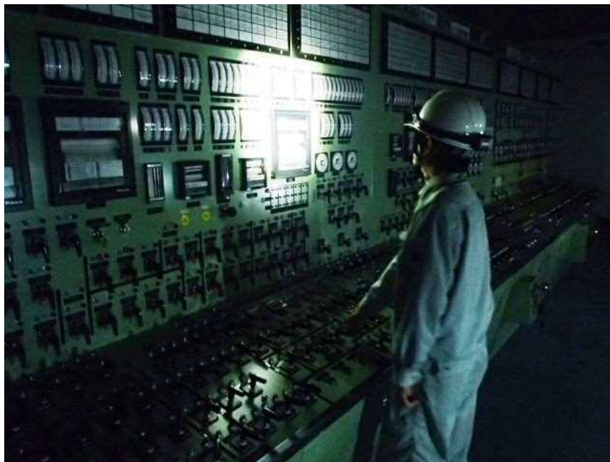
（シミュレーション施設におけるヘッドライト使用状況）
