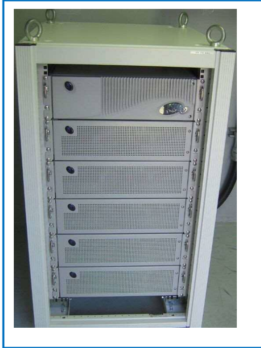
無停電電源装置
