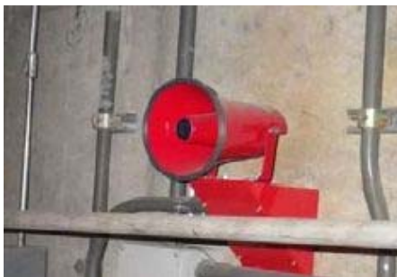
退避サイレン用音響装置
