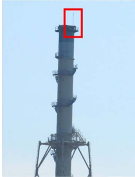
第41-1-16図 排気筒の避雷設備
