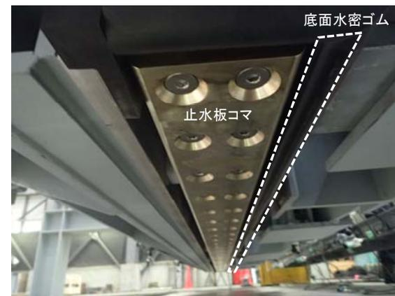
写真③ 底面水密ゴムと止水板コマ
