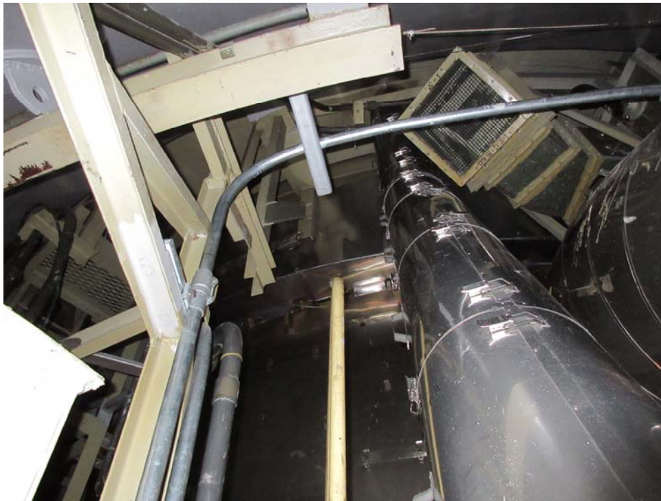
第 7 図 原子炉格納容器上部
