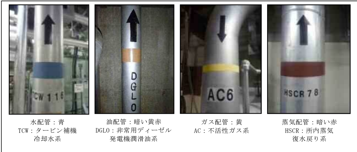
第 2.4.2-2 図 配管の識別管理（例）
