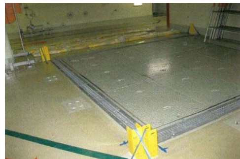
支柱レールの取付状況
