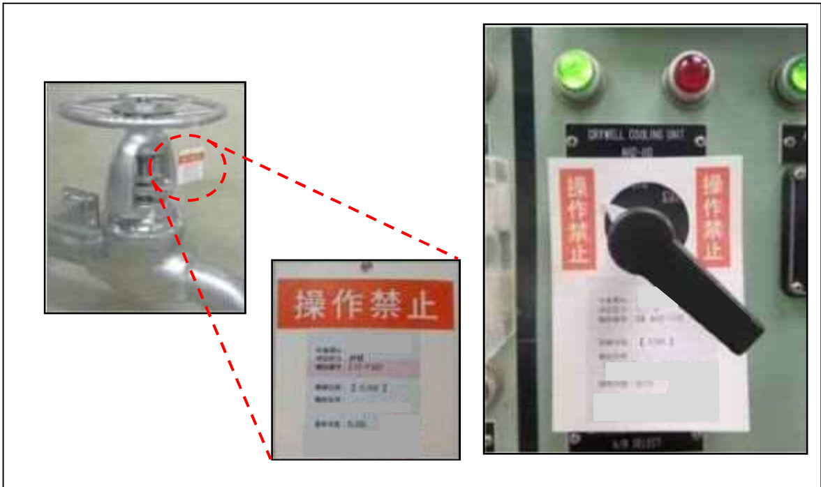
第 2.4.3-1 図 操作禁止札による識別（例）
