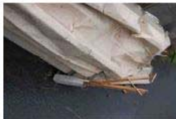
飛散した折板屋根の損傷状況
