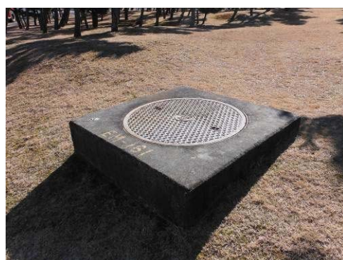
#186 マンホール蓋
