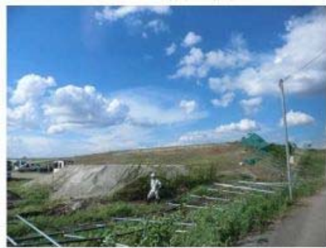
フェンスの倒壊
