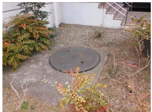
#49 マンホール蓋
