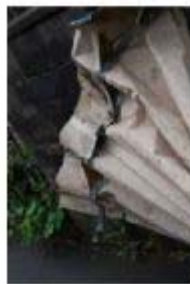
飛散した折板屋根の損傷状況
