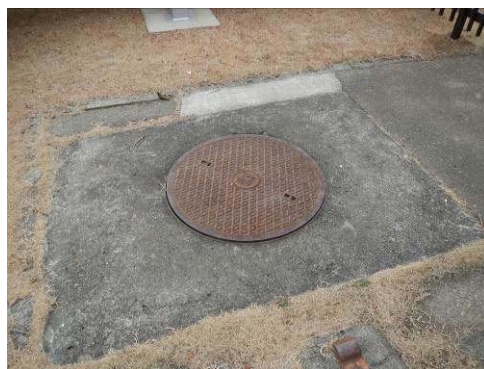
#246 マンホール蓋
