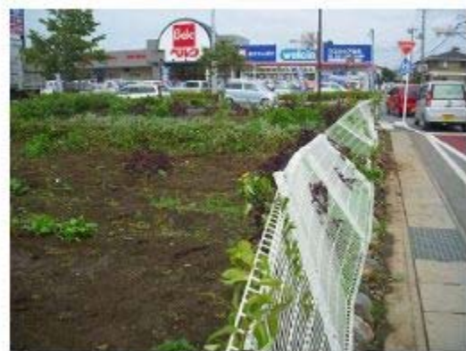
フェンスの変形
