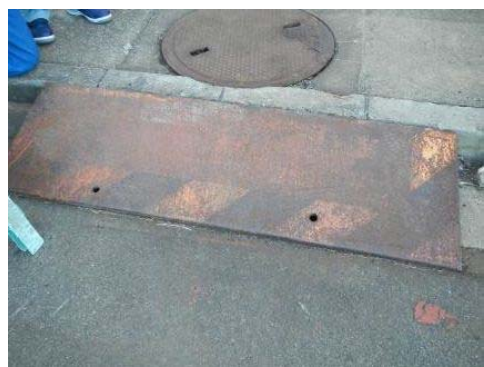
#335 鋼製スロープ
