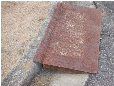
#34 鋼製スロープ
