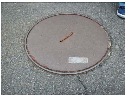
#316 マンホール蓋
