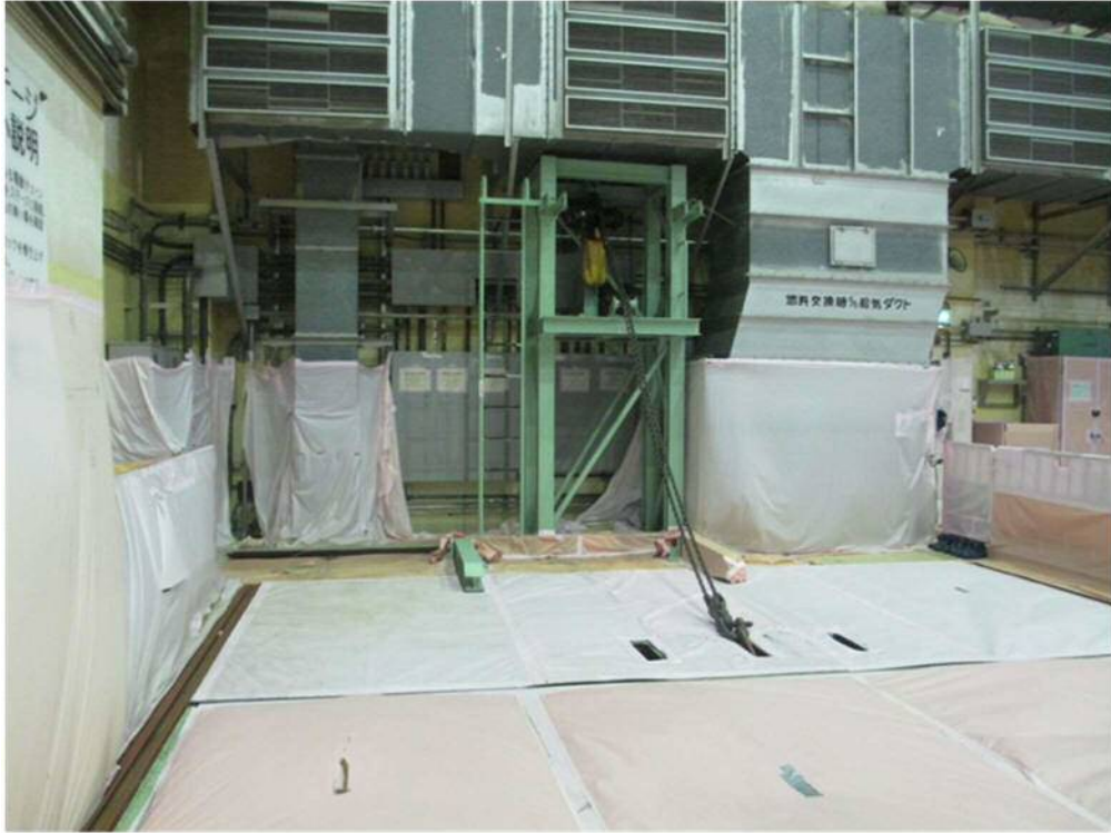
第1図 大物搬入口ハッチの閉状態
