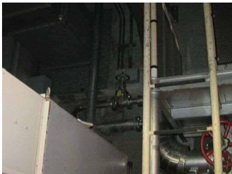
系統構成 （補助ボイラ冷却水元弁）
