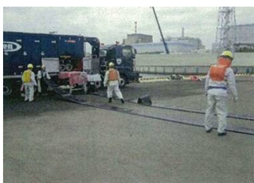
東海港での送水訓練 (ホース敷設)
