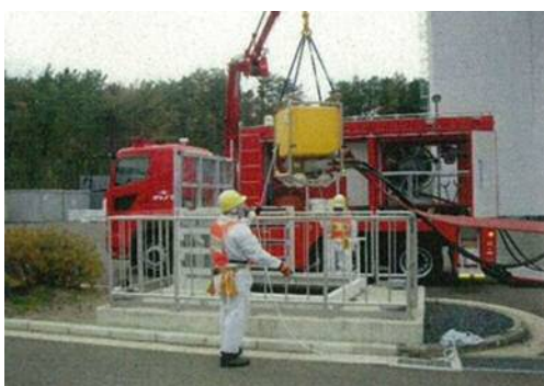
放射線防護具着用による送水訓練 （水中ポンプユニット設置）
