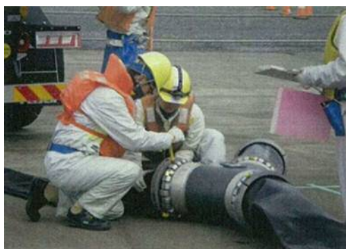
ホース接続訓練
