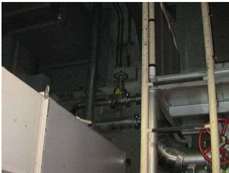
系統構成 (補助ボイラ冷却水元弁)
