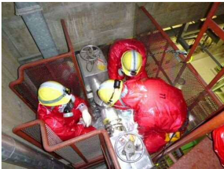
連絡配管閉止フランジ切替え訓練
