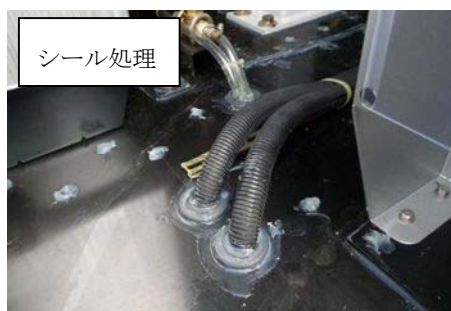
第1図 可搬型設備 小動物対策例 (1/2)
