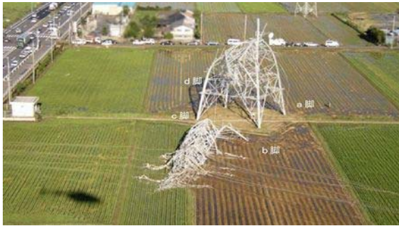
強風による鉄塔の倒壊事例① ※1
