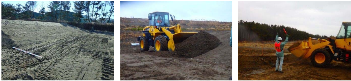
撤去作業開始
