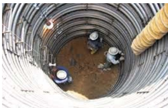
図 5.14.5-3 ライナープレート施工状況
