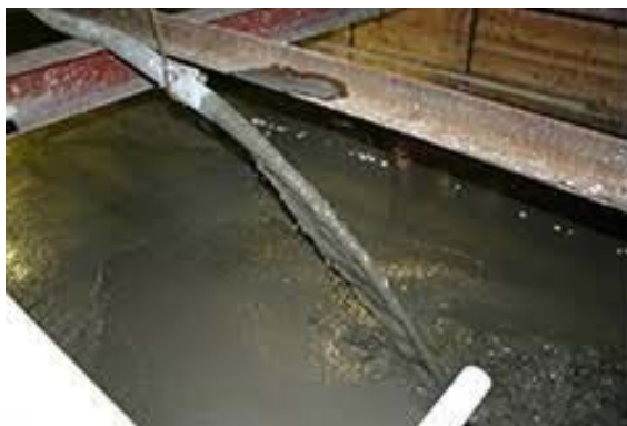
図 5.14.5-7 流動化処理土打設状況
