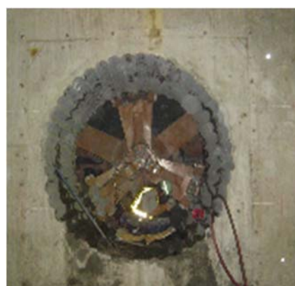
図 5.14.5-4 連続コアによる削孔
