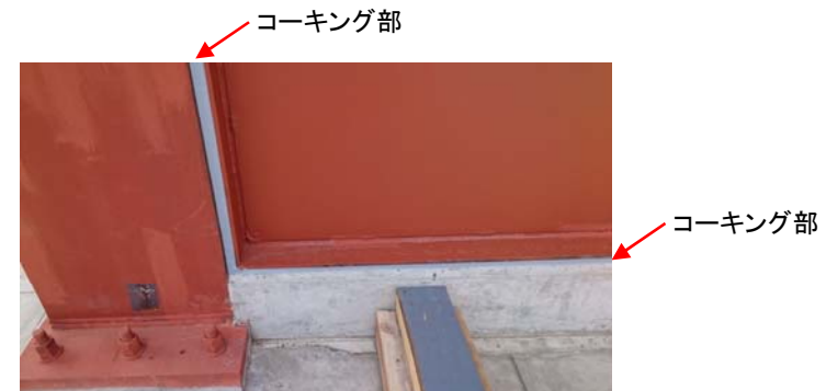
コーキング施工状況(パネル下部)
