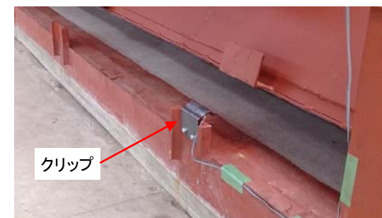
クリップ開放状況(パネル下部)
