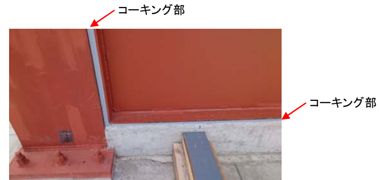
コーキング施工状況(パネル下部)
