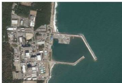
写真① 東海第二発電所全景
