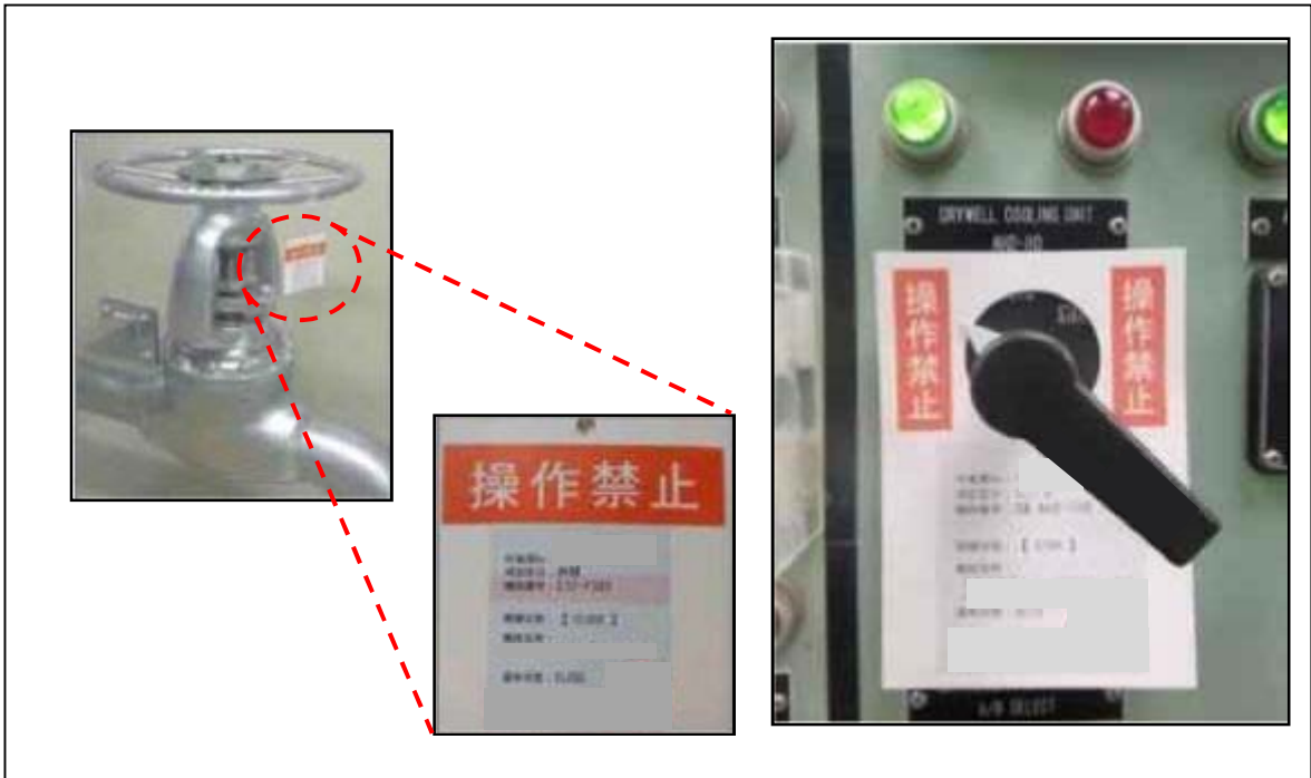
第 2.4.3-1 図 操作禁止札による識別 (例)
