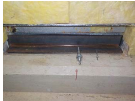
第7図 床貫通部模擬作業状況
