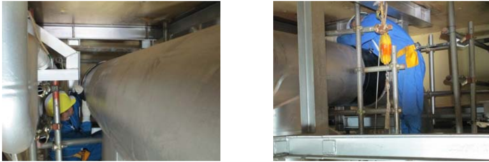
第2図 狭隘部作業状況
