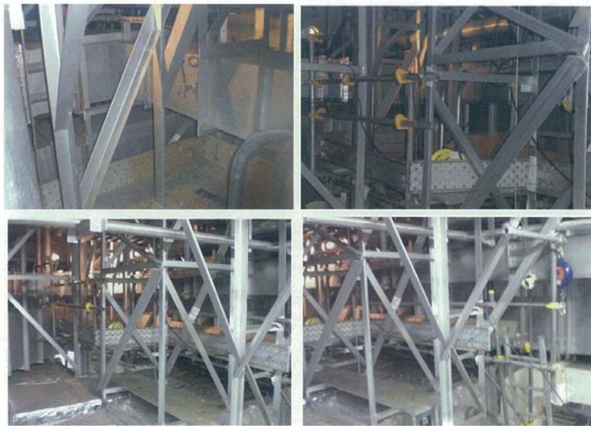
第4図 現場モックアップ状況（足場組立全景）
