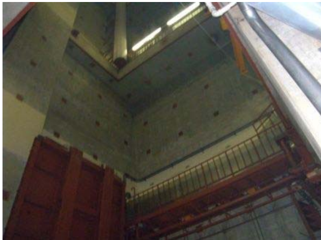
2階から3階機器ハッチ開口状況
