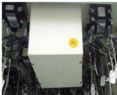
金属製筐体：厚さ 1.6mm 以上 （約 3.2mm）
