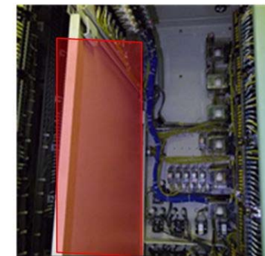
金属バリア：厚さ 3.2mm 以上 （約 4mm） 離隔距離：3cm 以上 （約 3cm 以上）
