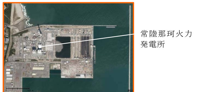
写真④ 茨城港常陸那珂港区周辺状況
