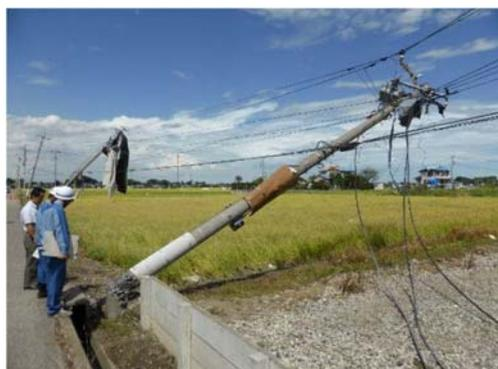
電柱の倒壊
