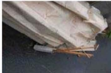
飛散した折板屋根の損傷状況
