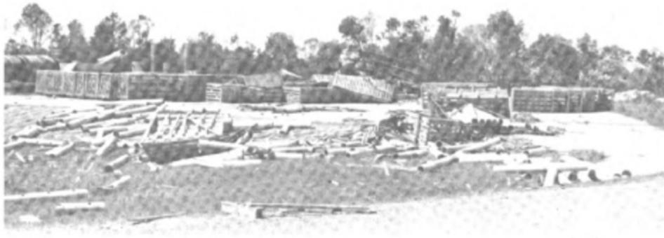
パイプを収納した木箱（一部 2 段重ね）は浮上せず倒れ、パイプが周囲 7m～9m に散乱
