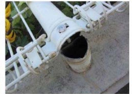
フェンス支柱部の破損
