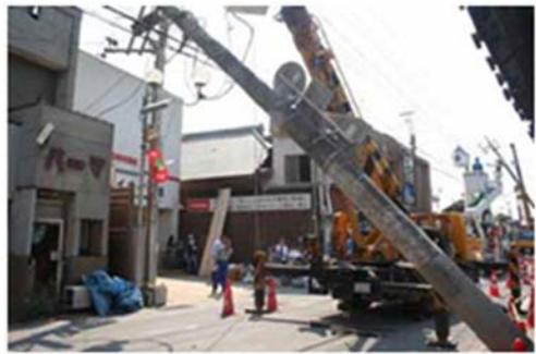
倒れた電柱(復旧作業時)
