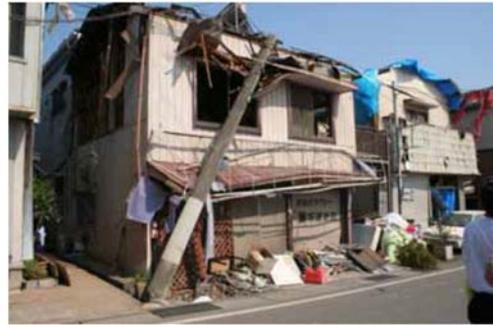
倒壊電柱に直撃された家屋
