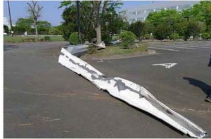
飛散した飛来物（鋼板製屋根材）
