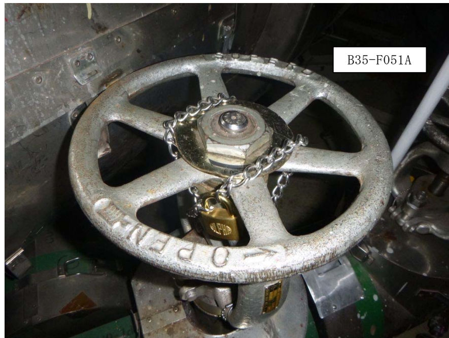
第 2-2 図 原子炉再循環ポンプ（A）系C U W入口ドレン弁 施錠状態
