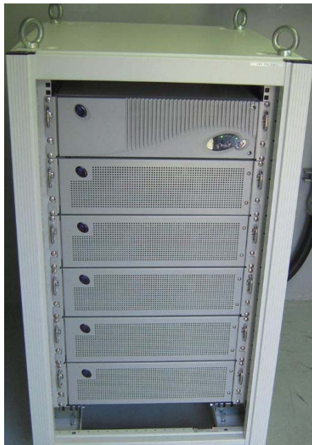
無停電電源装置
