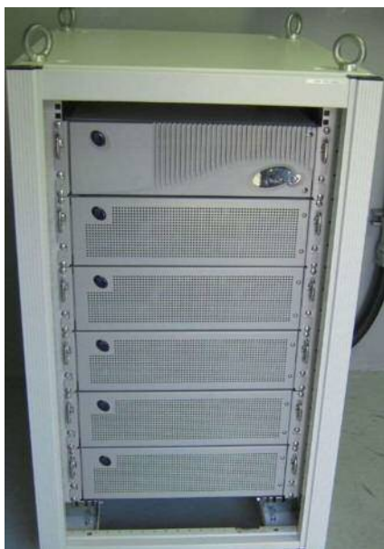
無停電電源装置
