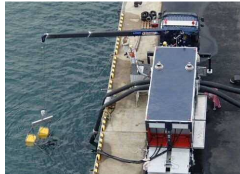
水中ポンプの設置状況
