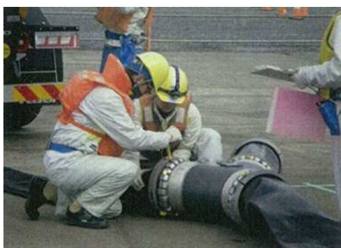
ホース接続訓練
