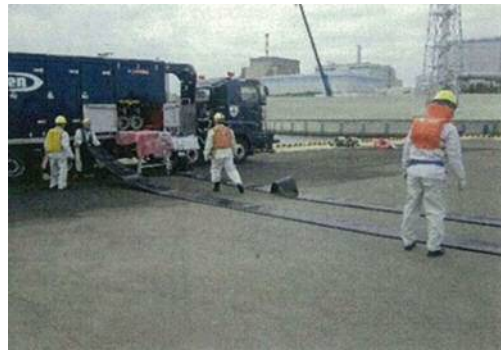
東海港での送水訓練 (ホース敷設)
