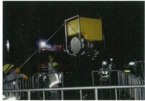
夜間での送水訓練（ポンプ設置）
