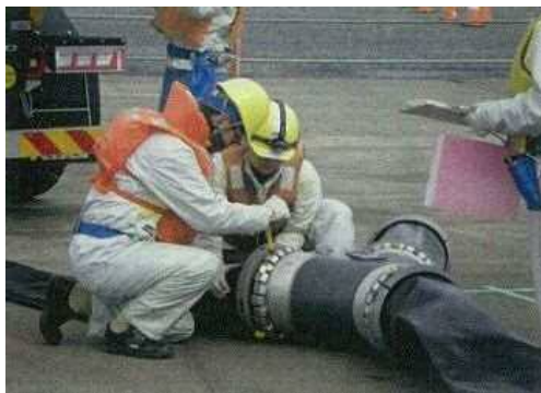
ホース接続訓練
