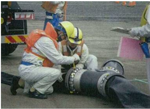
ホース接続訓練
