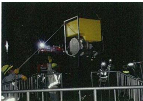
夜間での送水訓練（ポンプ設置）
