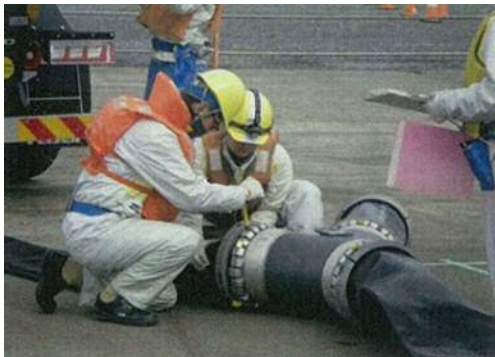
ホース接続訓練
