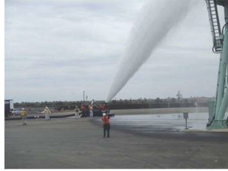
放水砲による放水（噴霧放射）
