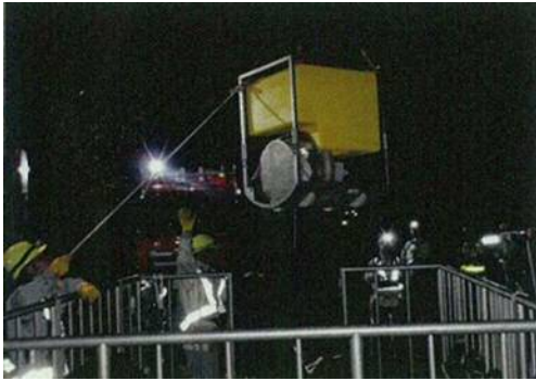
夜間での送水訓練（ポンプ設置）
