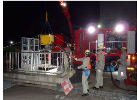
(暗所環境下での 作業状況の例)
