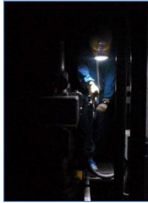
(可搬照明を使用した 状態での作業)
