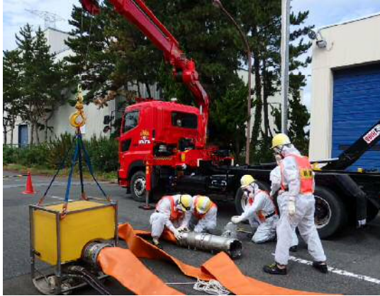
第 1.0.13-3 図 放射線防護具類を着用した状態での可搬型代替注水ポンプ車の設置作業
