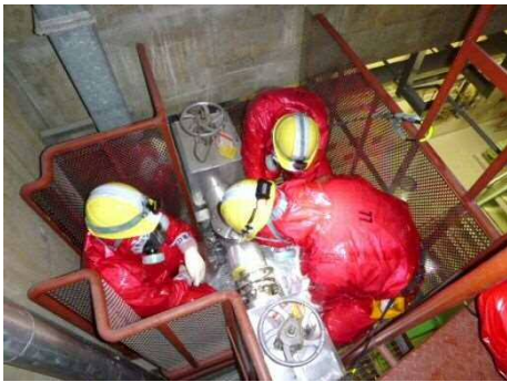
連絡配管閉止フランジ切替え訓練
