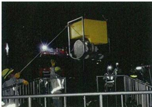
夜間での送水訓練（ポンプ設置）
