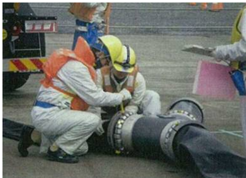
ホース接続訓練
