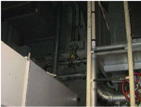
系統構成 (補助ボイラ冷却水元弁)
