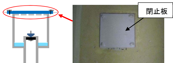
第9.11-13図 床ドレンファンネルの閉止例
