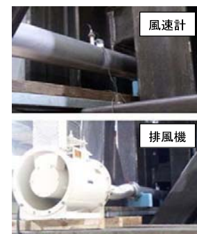
第10図 排風機及び風速計設置状況
