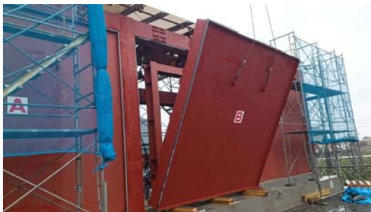
パネル開放状況
