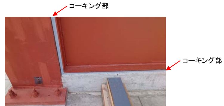
コーキング施工状況(パネル下部)
