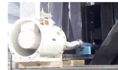
第3図 排風機及び風速計設置状況
