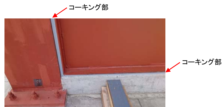
コーキング施工状況(パネル下部)
