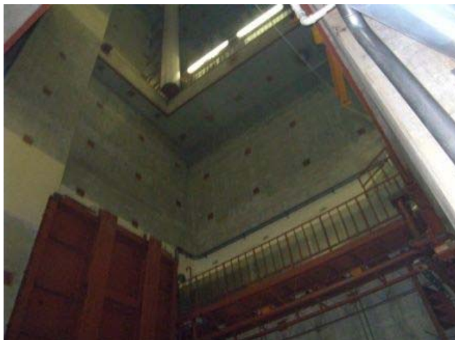
2階から3階機器ハッチ開口状況
